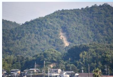
岡谷地区で発生した土砂崩れ
