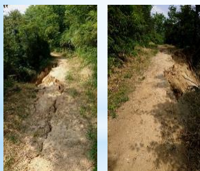
頂上東の鳥居から下へ約20m、道の2/3が下の片山側へ崩れる。
