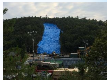
宿地区で発生した土砂崩れ
