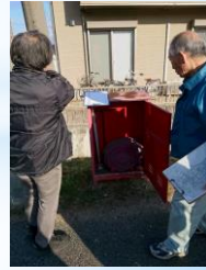
消火栓の点検
